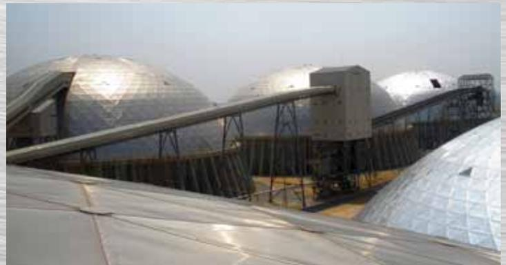
“CST顶盖”提供多种结构与高强度铝合金设计方案，包括：网壳、拱顶、挤压式扁平顶盖、成型盖板、桁架支撑顶盖、空间结构，以及为客户独特的储存应用而特别设计的定制产品。
