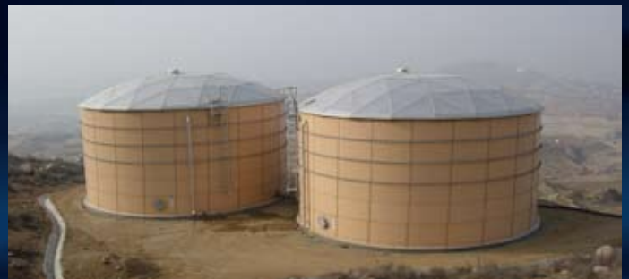
▲ Instalaciones de tanques múltiples de Almacenamiento Potable.
