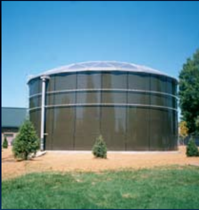
Tanque de Almacenamiento superficial
